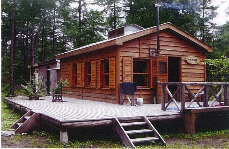
カラマツの間伐材を利用して建てた、ウヨロ環境トラストの拠点「ウヨロ小屋」
